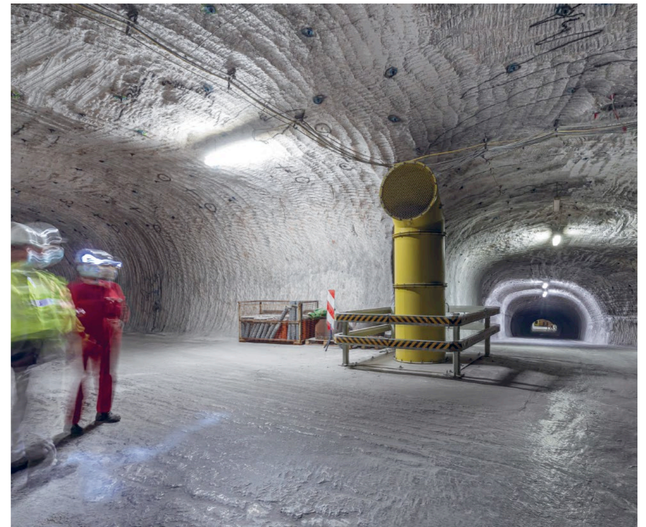
Gorleben mine: Exhaust air conduit, 820 m level
